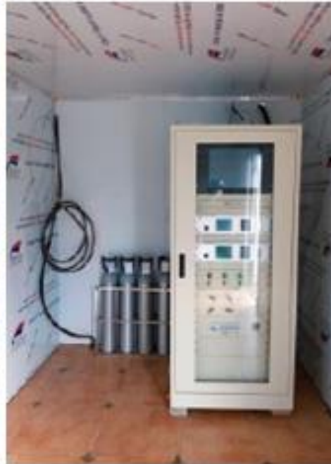
Quan trắc lò đốt rác sinh hoạt
